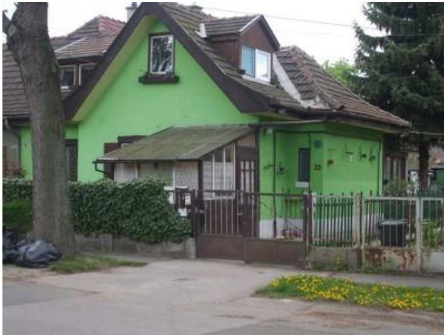
2.4. kép. Az arculatot elcsúfító előszoba hozzátoldás, és a jelenlegi szabályoknak nem megfelelő „kutyaház ablak” (Forrás: ELTINGA kép)
