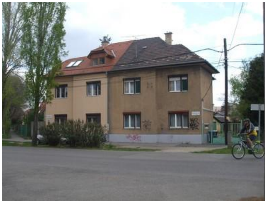
2.2. kép. Az eredeti osztások már hiányoznak, egyes ablakok műanyagra cseréltek, felhelyezett redőnyök, spaletta hiány (Forrás: ELTINGA kép)
